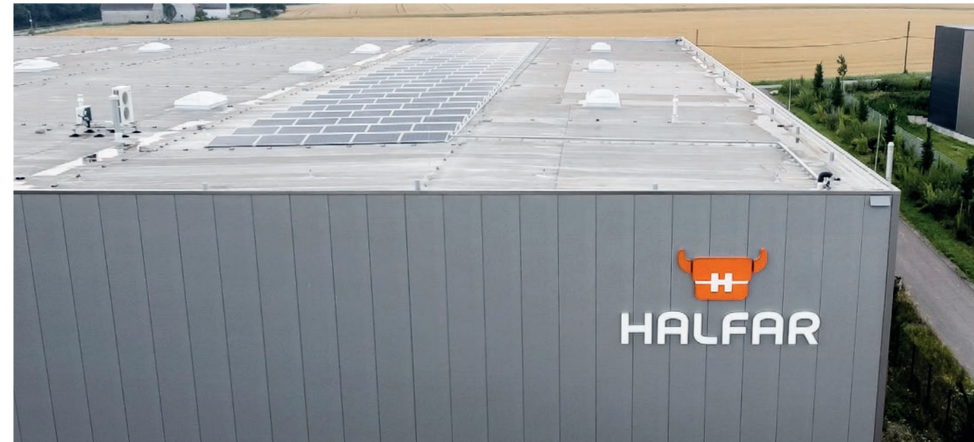
Logistikzentrum/Bielefeld Altenhagen – PV-Anlage auf dem Dach
